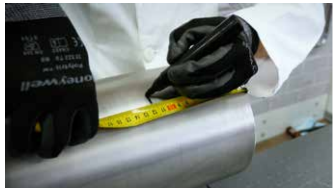
Figura 15 - Marcatura della profondità d'innesto
