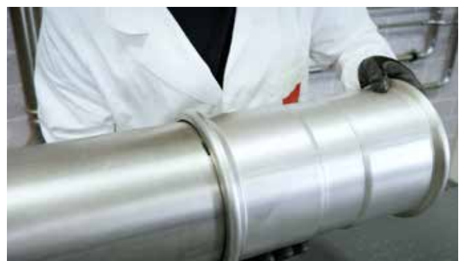
Figura 17 - Inserimento del tubo nel raccordo a pressare
