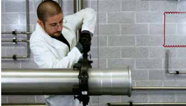
Figura 18 - Assemblaggio pressatura n°1
